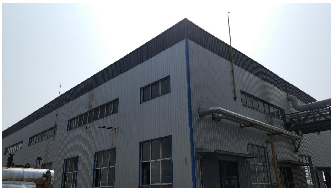
图 3-4 动力车间（锅炉房）外景
