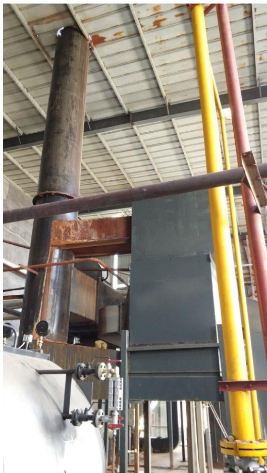
图 3-6 锅炉房 6t/h 燃气锅炉和 500 万大卡 导热油炉 共用 1 根 8m 高排气筒
